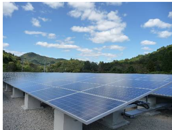
(福崎太陽光発電所)
