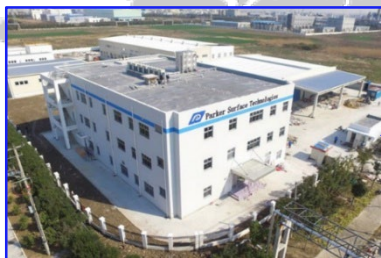
パーカー表面処理技術(上海)有限公司
