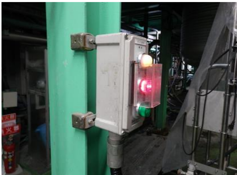
①通行時に操作ボタンへの誤接触防止の樹脂カバー
