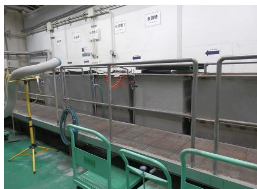
②化成処理ラインの歩廊に手摺を設置
