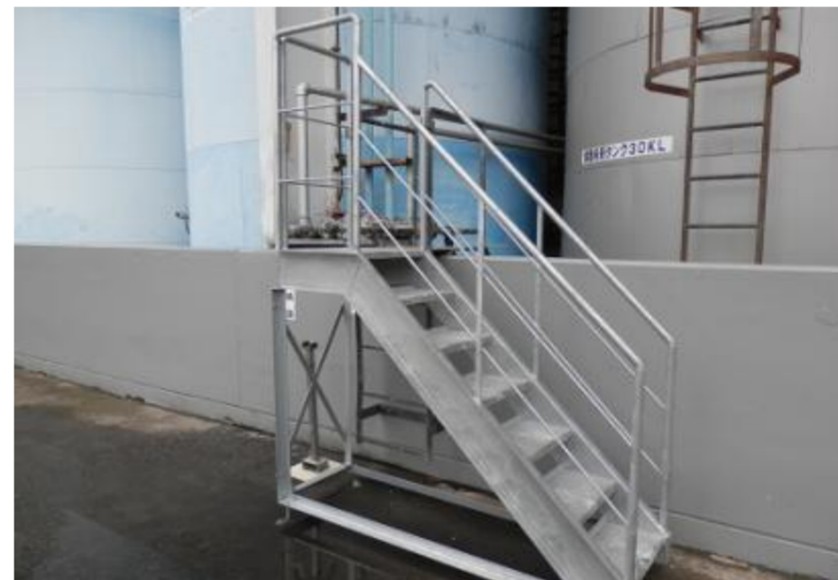
②リン酸タンクへのアプローチ階段の新設
